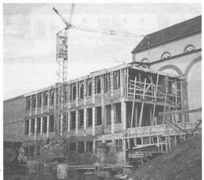
Bau des Schulgebäudes (Foto aus dem Jahr 1958)
