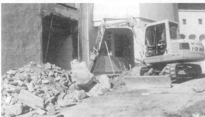
Öffnungen für das neue Stiegenhaus an der Ostseite.
