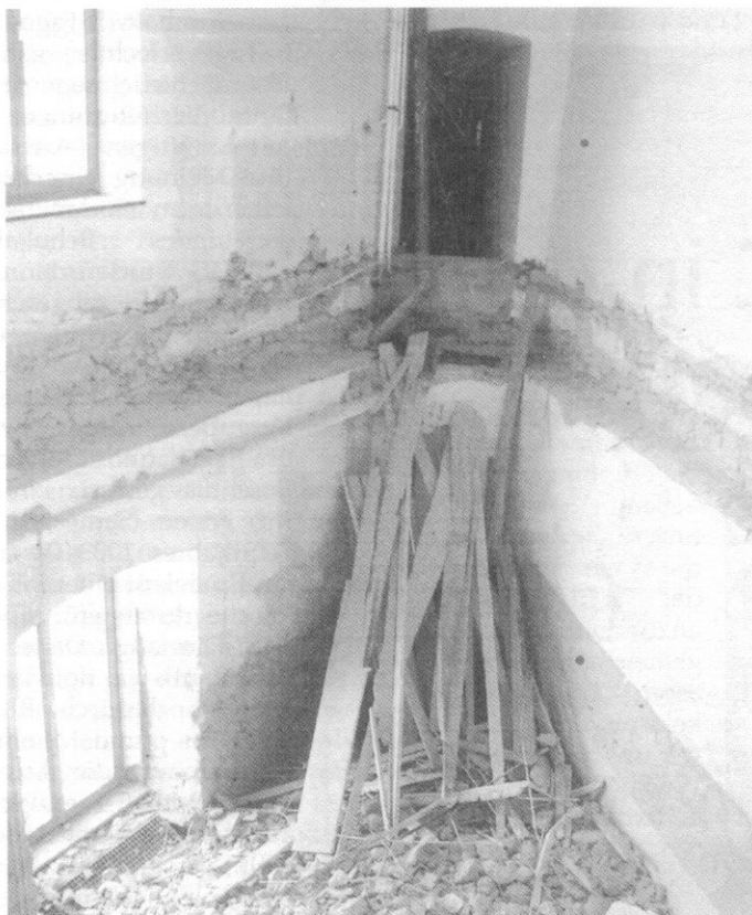
Abgetragene Decke beim Turm.
