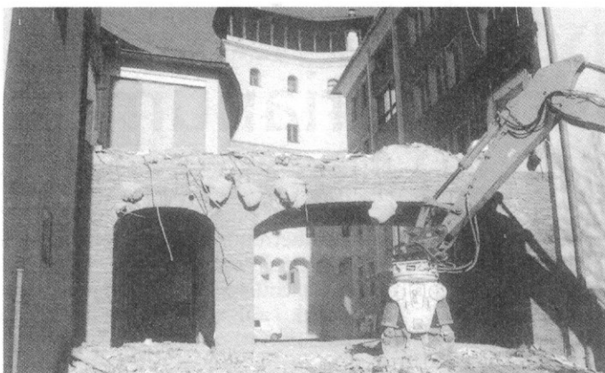
Abbruch des Verbindungsganges in den Neubau.
