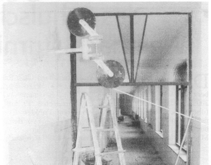
Neue Maueröffnungen werden herausgeschnitten.
