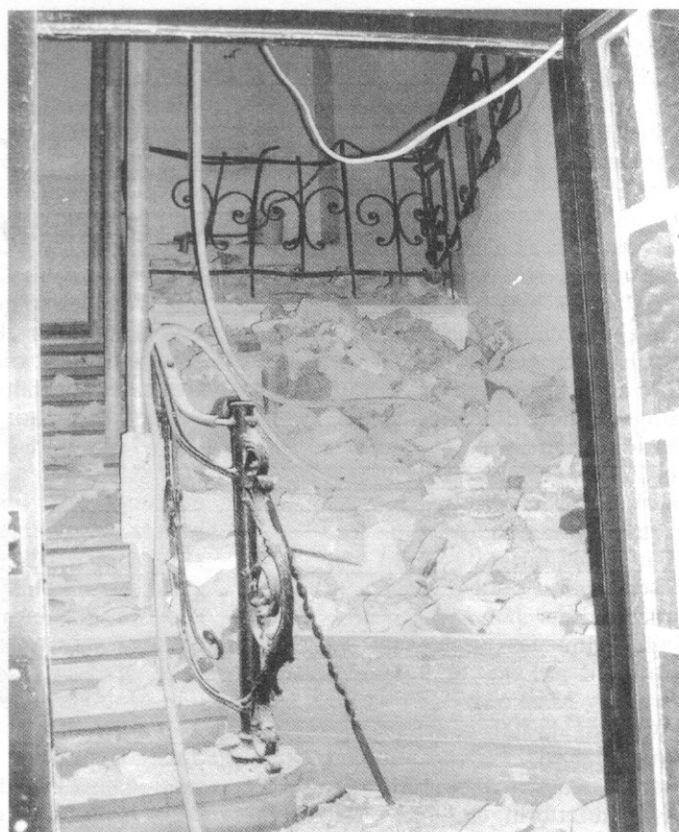
Abbruch Stiege Nord.
