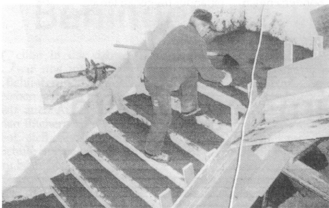
Stiegenhaus Nord wird betoniert.
